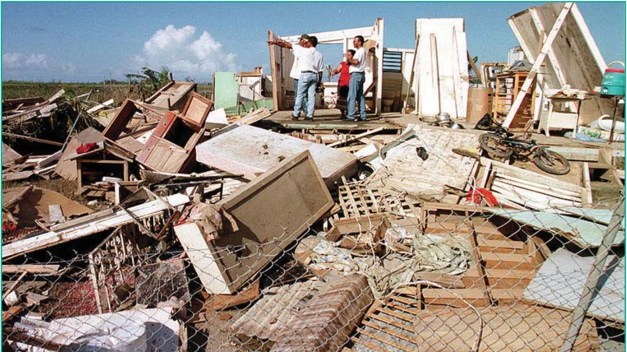
Toa Baja, PR, 1 de Octubre de 1998 - Una familia en la Barriada de la Villa del Sol en Toa Baja, observa los daños causados por las inundaciones y el viento a su hogar, junto con FEMA y funcionarios de Defensa Civil. Crédito de foto: FEMA; Dave Gatley
